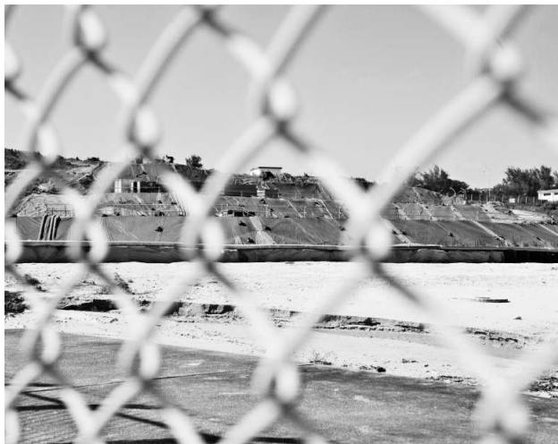
ダンプで持ち込まれた土に台風除けのブルーシート
